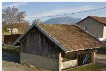
Ex: Lavoir Rue de Saint-Ange
