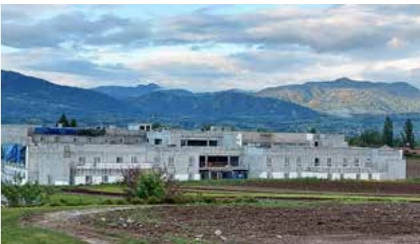
Travaux du futur Hôpital Local Départemental - Rue de Bersat.
